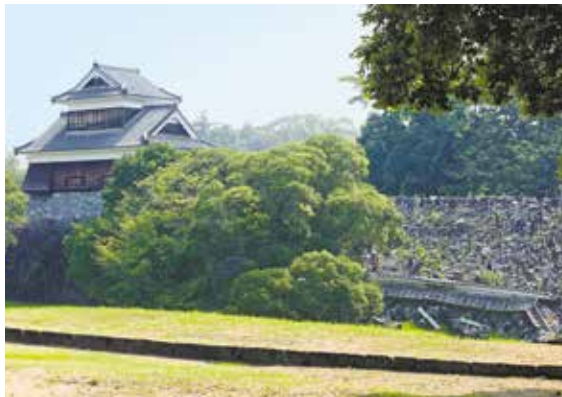
2度の地震により、甚大な被害を受けた熊本城。天守閣は、特殊なゴムを使って揺れを吸収するダンパーや鋼管が取り付けられ、復旧作業とともに耐震化工事が進められている。
