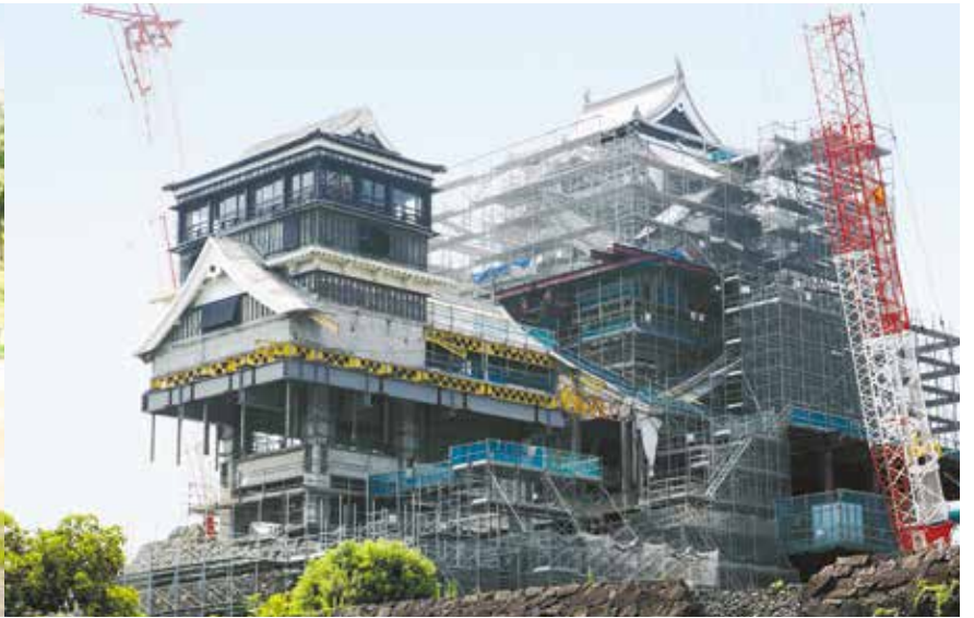
2度の地震により、甚大な被害を受けた熊本城。天守閣は、特殊なゴムを使って揺れを吸収するダンパーや鋼管が取り付けられ、復旧作業とともに耐震化工事が進められている。
