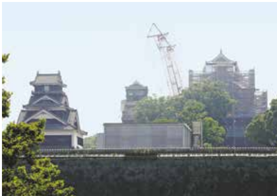
2度の地震により、甚大な被害を受けた熊本城。天守閣は、特殊なゴムを使って揺れを吸収するダンパーや鋼管が取り付けられ、復旧作業とともに耐震化工事が進められている。
