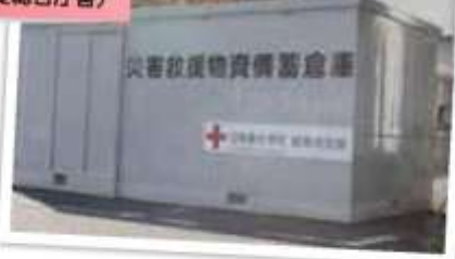
防災拠点備蓄倉庫 (揖斐総合庁舎)
